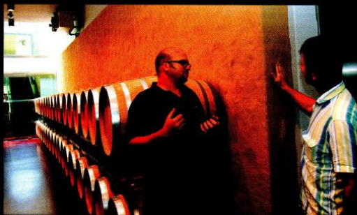
Gerhard Rouschal a Peter Šroner pri pieskovcovej stene, ktorá pomáha udržiavať stabilitu vlhkosti a teplotu v barikovej hale
